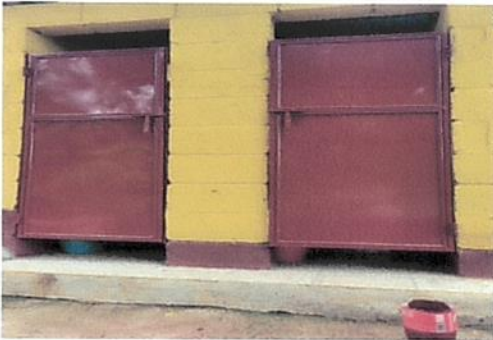
Foto 9: Mantenimiento de puertas de baño y una bodega.
