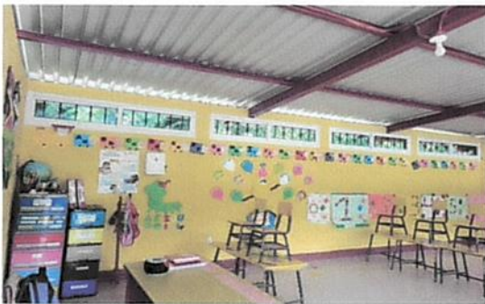
Foto 5: Colocación de ventanas de PVC del establecimiento
