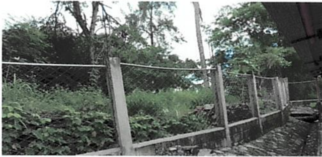
Foto 3: Cambio de malla de 1.50 metros
