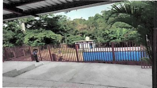
Foto 8 Mejoramiento de torta de concreto (nivelación y alizado)
